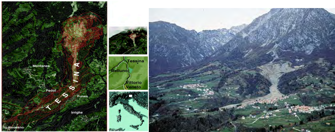
Figura 3.15. El Valle Tessina en el borde Bellunese de los Alpes italianos, se ha visto afectada por problemas de inestabilidad por lo menos desde 1960. El deslizamiento de tierra se extiende por 2,5 kilómetros a través de la ladera sur del monte Teverone y el mayor deslizamiento de tierra se activó después de intensas lluvias en octubre de 1960; fallos posteriores se produjeron en 1963 y 1992. Se han instalado una serie de sistemas de instrumentación y de advertencia.
